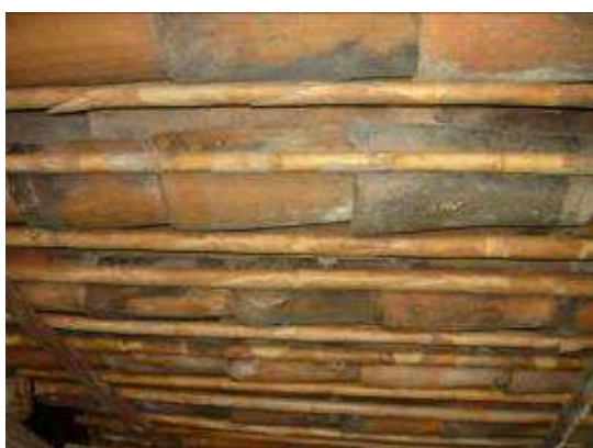
Techo reparado en caña menuda y teja de barro
