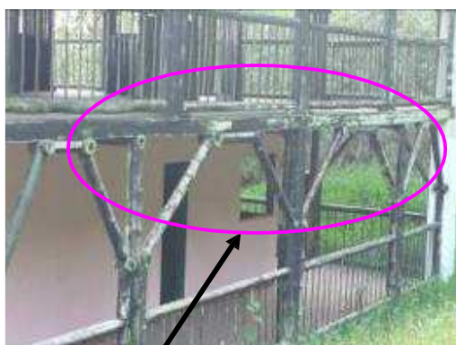
Estructura y techo en guadua y esterilla, completamente afectada de hongos
