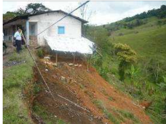
Agrietamiento de vivienda por inestabilidad de suelos-derrumbamiento
