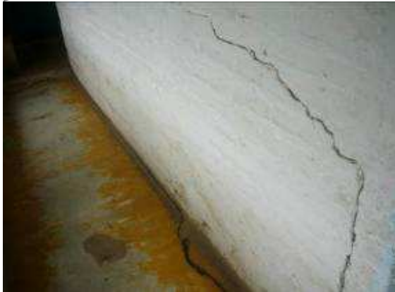
Agrietamiento de vivienda por inestabilidad de suelos-derrumbamiento
