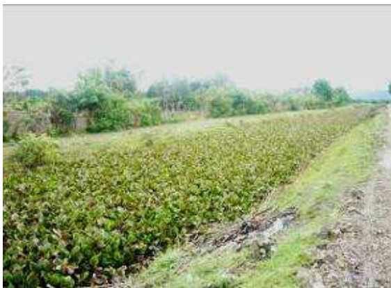
Canal de riego RUT en jurisdicción del municipio (sector El Banco), en un amplio tramo invadido de buchón de agua, falta de mantenimiento
