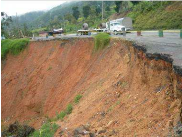
Derrumbe en la vía Cabal Pombo, afectando fuentes de trabajo y estabilidad de la vía
