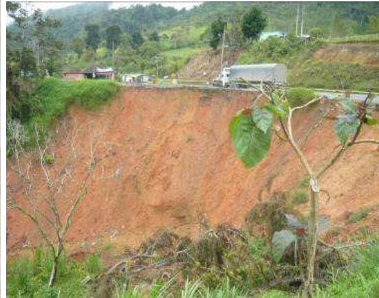
Derrumbe en la vía Cabal Pombo, afectando fuentes de trabajo y estabilidad de la vía
