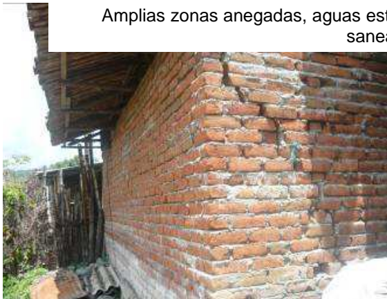
Agrietamiento de paredes
