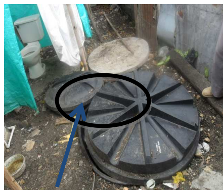
Inadecuada instalación y funcionamiento de Pozo séptico -corregimiento Potrerito, sin conservar las mínimas distancias
