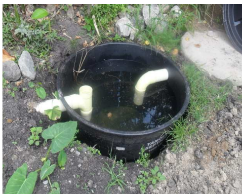
Inadecuada instalación y funcionamiento de Pozo séptico -corregimiento Potrerito, sin conservar las mínimas distancias
