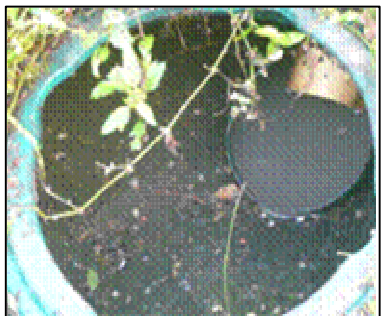
Ausencia de bacterias anaerobias en razón de la utilización de hipoclorito. Tuberías expuestas que pueden ser colapsadas por golpes o por pisoteo de la personas.
