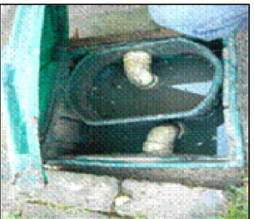
Ausencia de bacterias anaerobias en razón de la utilización de hipoclorito. Tuberías expuestas que pueden ser colapsadas por golpes o por pisoteo de la personas.
