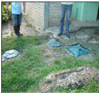
Estado de los pozos sépticos, enmalezados, colmatados, con presencia de jabones, detergentes e hipoclorito de sodio.
