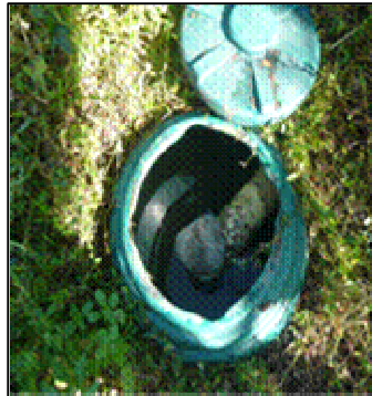
Estado de los pozos sépticos, enmalezados, colmatados, con presencia de jabones, detergentes e hipoclorito de sodio.
