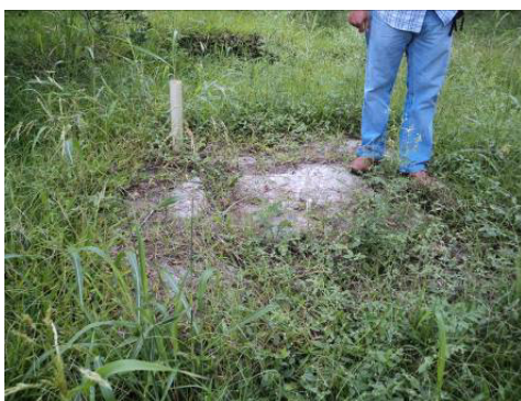
Pozos sépticos enmalezados falta de mantenimiento
