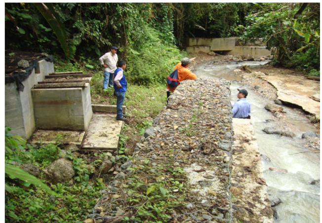
Estructuras de contención y Bocatoma de la quebrada
