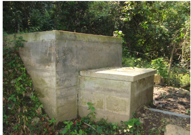
Estructura desarenadora Confinada
