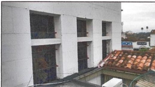
FOTO DE LOS VITRALES CON FILTRACION GENERANDO HUMEDADES
