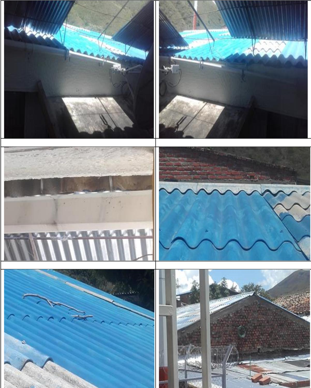
Se evidencia cubierta con ocho (8) tejas instaladas en asbesto cemento aparentemente no son nuevas o de primera calidad, por cuanto a simple vista se observa cierto desgaste en las mismas, además de que fueron muy mal pintadas.
