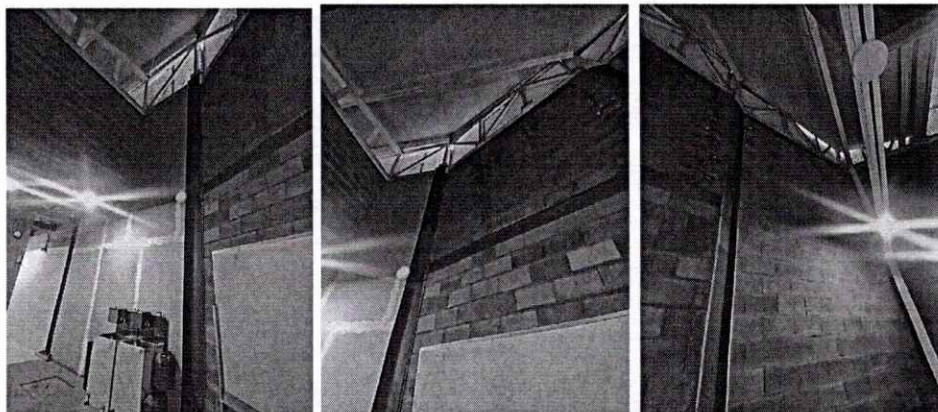
Estado actual eje 3"-G _Sin arriostramiento
