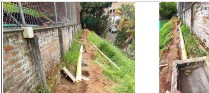
En la foto No. 1 se aprecian las excavaciones donde se localizan las zapatas, en la foto No. 2 ya se ven los concretos fundidos zapata + pedestal
