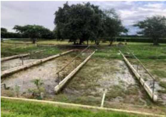
Cama de lechos de secado sin cubierta Fuente de Criterio y Criterio
