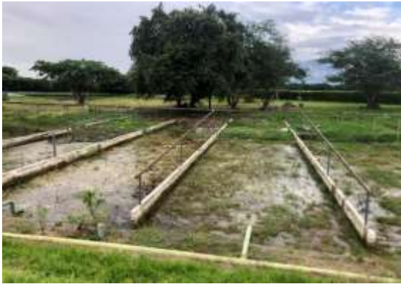
Cama de lechos de secado sin cubierta
